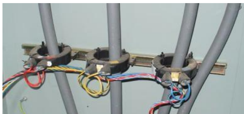
Рис. 5.5 Устройство для приёма сигнала обратной связи
