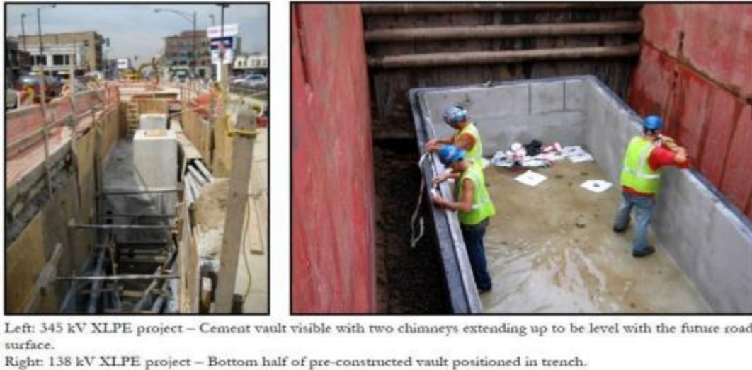
Рис 9.1 Туннели для подземной трёхфазной системы
